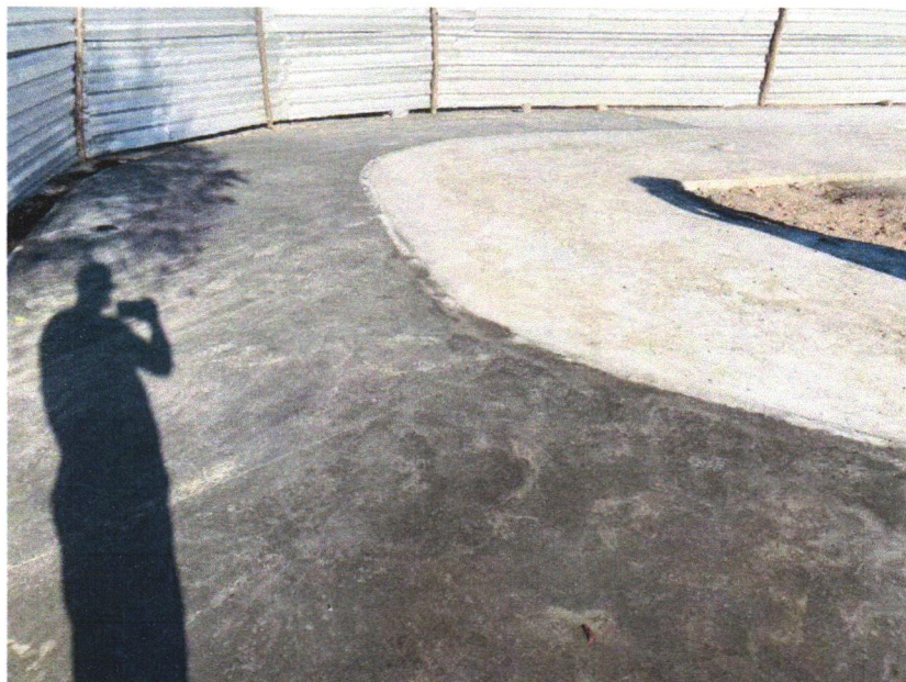
Foto 02 – PAVIMENTAÇÃO EM CONCRETO, COM ESPESSURA DE 7 CM, COM ACABAMENTO FEITO UTILIZANDO ALISADORA DE CONCRETO (HELICOPTERO), INCLUIDO TELA DE AÇO SOLDADA NERVURADA CA60, Q196 (3,11 KG/M 2 ), DIÂMETRO DO FIO 5.0 MM, LARGURA = 2,45 M, ESPAÇAMENTO DA MALHA = 10 X 10 CM, JUNTA DE DILATAÇÃO EM PVC A CADA 2,00 M, CONCRETO FCK = 20 MPA
