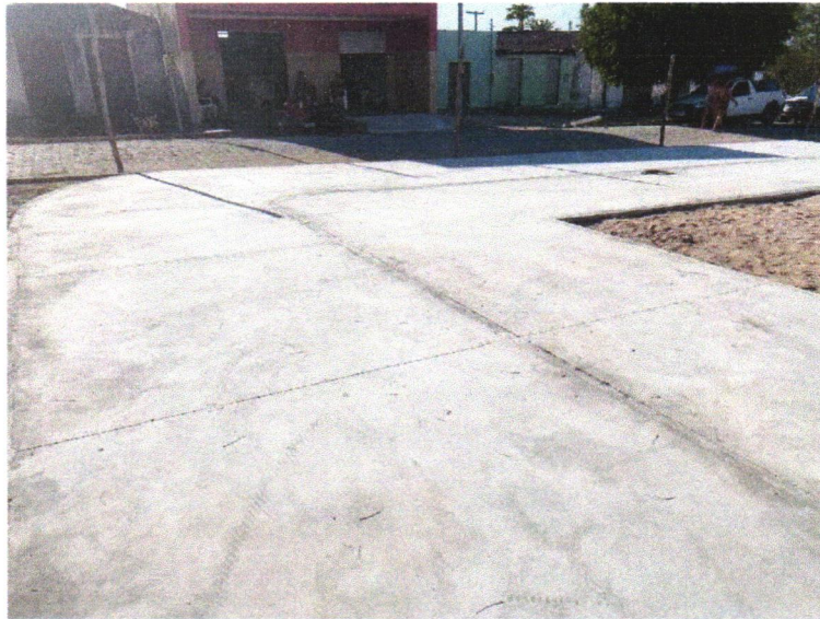
Foto 01 - PAVIMENTAÇÃO EM CONCRETO, COM ESPESSURA DE 7 CM, COM ACABAMENTO FEITO UTILIZANDO ALISADORA DE CONCRETO (HELICOPTERO), INCLUIDO TELA DE AÇO SOLDADA NERVURADA CA60, Q196 (3,11 KG/M 2 ), DIÂMETRO DO FIO 5.0 MM, LARGURA = 2,45 M, ESPAÇAMENTO DA MALHA = 10 X 10 CM, JUNTA DE DILATAÇÃO EM PVC A CADA 2,00 M, CONCRETO FCK = 20 MPA
